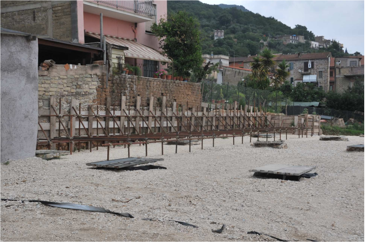
Lato a monte confine con abitazioni (muro di confine pericolante)
